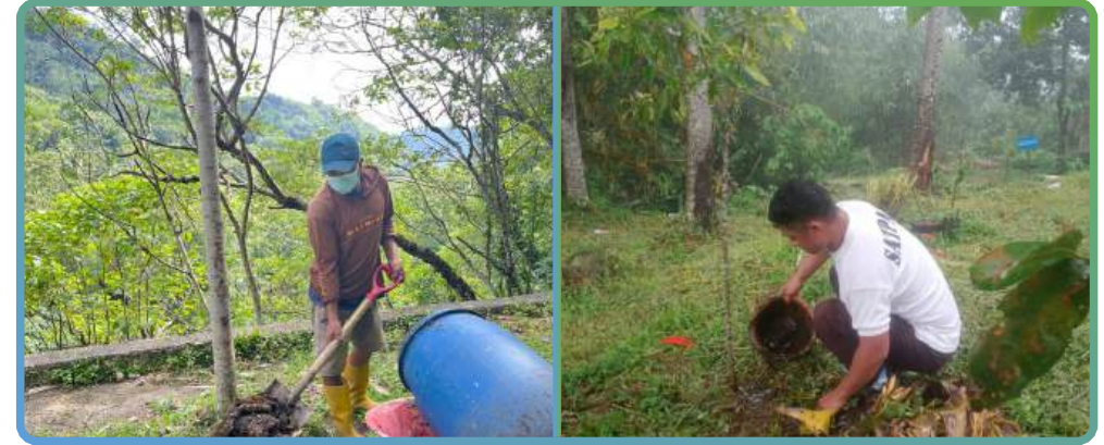
Gambar. Pembuatan kompos dari sisa makanan di PLTM Cianten 2 Composting Food Waste at Cianten 2 MHPP
