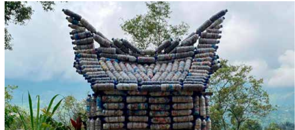
Tugu Rumah Gadang yang terbuat dari sampah plastik yang dipadatkan dalam 225 kilogram sampah plastik yang dimasukkan ke dalam 423 botol ecobrick 600 ml yang berlokasi di Jorong Tabek, Nagari Talang Babungo, Kecamatan Hiliran Gumanti, Kabupaten Solok, Sumatera Barat (PLTM Gumanti III). Tugu Rumah Gadang, made from compacted plastic waste weighing 225 kilograms, contained within 423 eco-bricks of 600 ml each, located in Jorong Tabek, Nagari Talang Babungo, Hiliran Gumanti District, Solok Regency, West Sumatra (Gumanti III MHPP).
